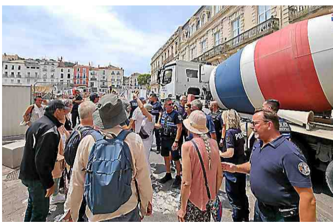
Bancs Publics a tenté de faire obstruction au chantier du parking. HA
